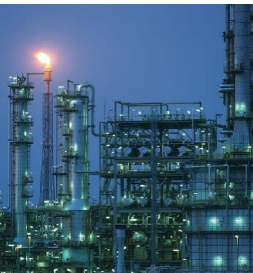
V oblasti uhľovodíkov: V tejto rafinérii sa surová ropa spracováva na benzín, naftu a vykurovací olej. (foto: Lurgi, Frankfurt nad Mohanom).
